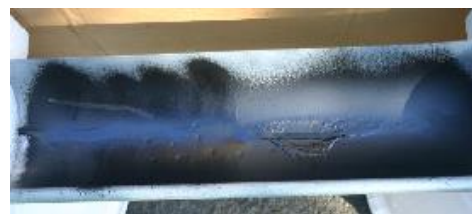
APRÈS APPLICATION ETANCHÉITÉ
